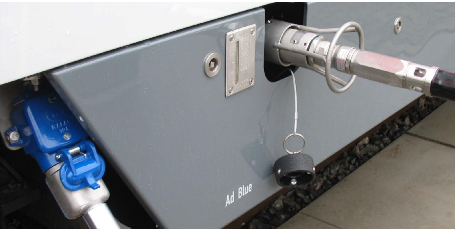
Schnittstelle zwischen Tank- anlage und Schienenfahrzeug
